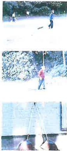
令和6年グラウンドゴルフコート整備
